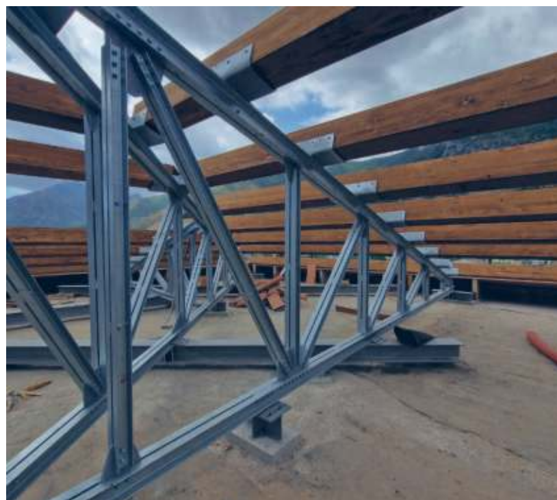
LAVORI DI RIFACIMENTO DEL SOLAIO E DELLA COPERTURA DI UN EDIFICIO A VENAFRO (IS)
