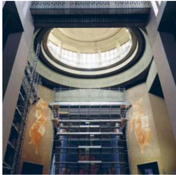
LAVORI DI CONSOLIDAMENTO E RESTAURO DI UN EDIFICIO DI CULTO
