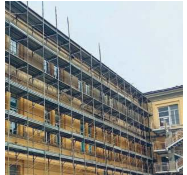
LAVORI DI RIFACIMENTO DI UN EDIFICIO SCOLASTICO
